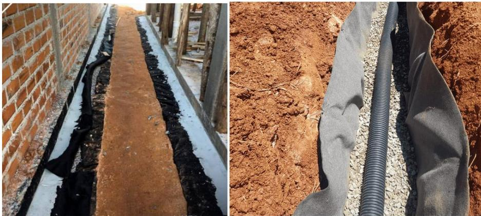
Figura 59 - Sistema de drenagem. Fonte: <https://www.lineastudio.com.br/drenagem-e-as-boas-praticas-em-obra/>
