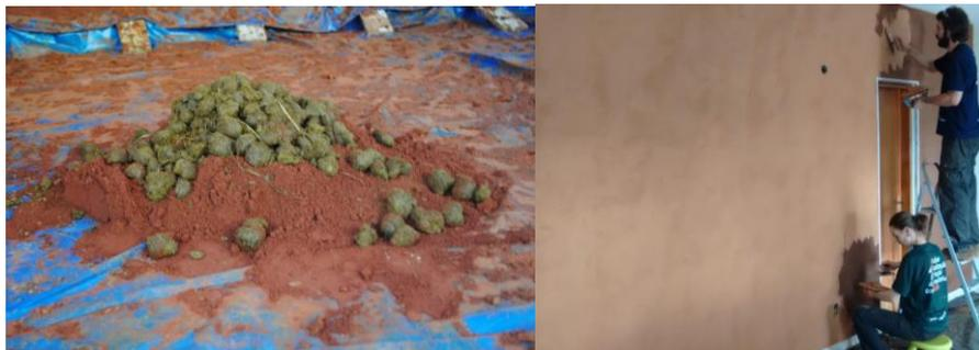
Figura 60 - revestimento com adição de esterco de vaca. Fonte: <http://www.ecoeficientes.com.br/como-fazer-um-revestimento-de-terra-na-parede/>
