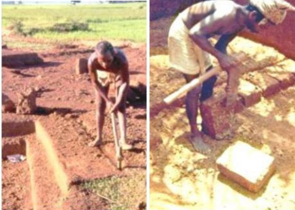
Figura 3 - Extração de Torrões. Fonte: (DUARTE, 2013) e Blocos talhados. Fonte: (DUARTE, 2013)
