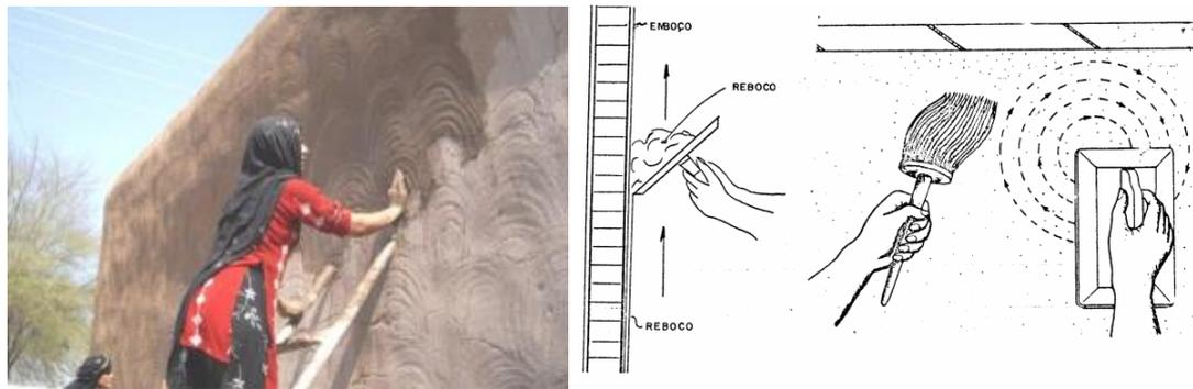
Figura 46 – Revestimento da Alvenaria e detalhe da aplicação do reboco. Fonte: (MILITO)
